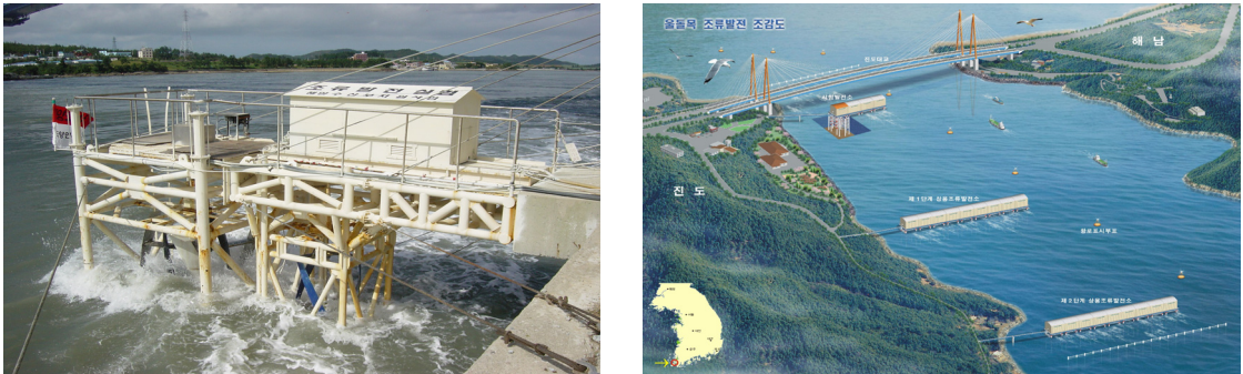
〈그림 3-95〉 조류발전 현장실험(좌), 울돌목 상용조류발전소 조감도(우)
